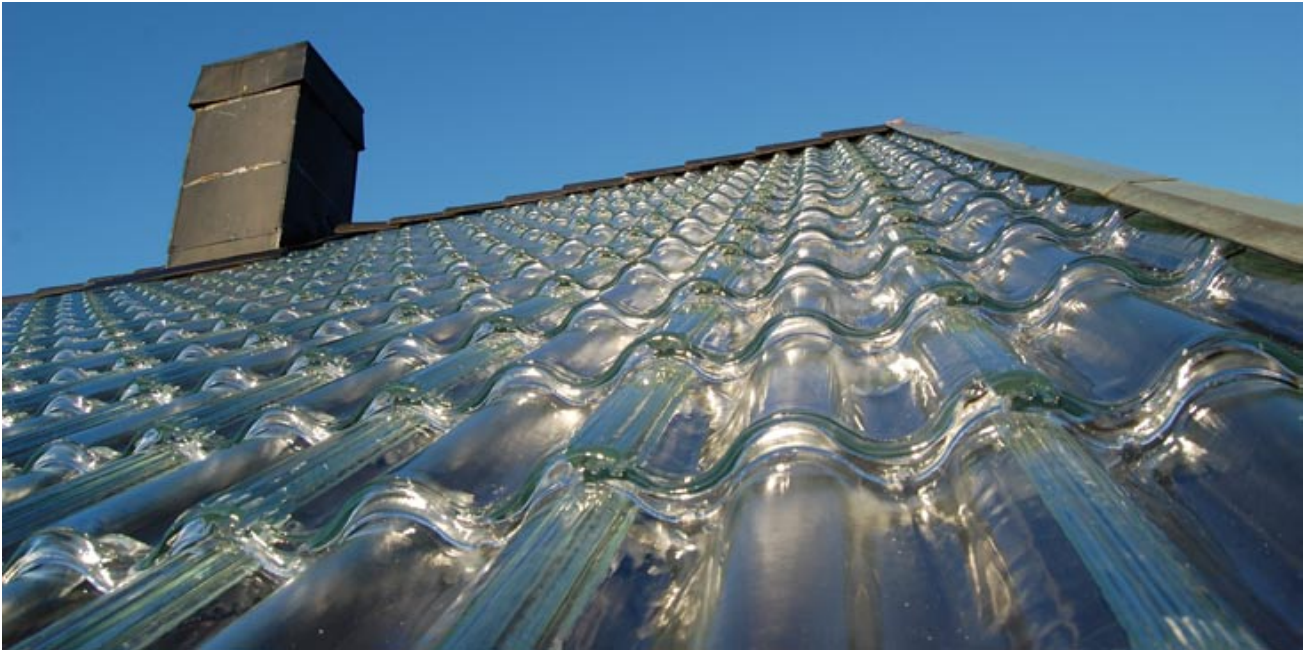
Det luftbaserade solenergisystemet Soltech System låter solen värma en luftspalt under takpannor av glas.
